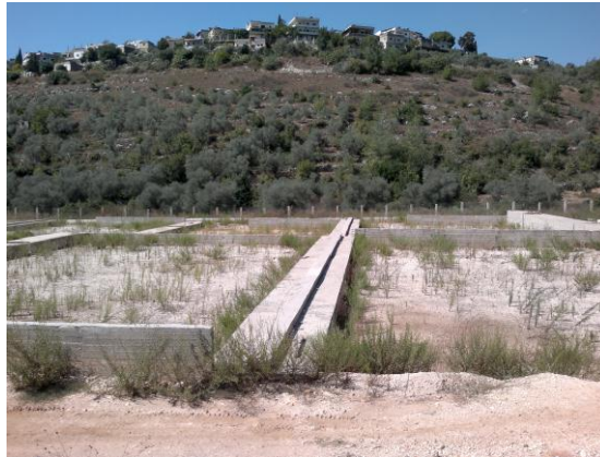
الصورة (13) تبين أحواض تخفيف الحمأة في محطة معالجة صافيتا (تصوير الطالبة).
